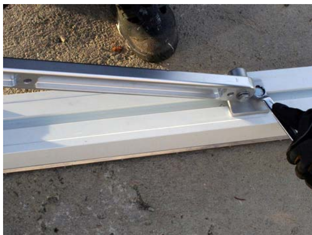
d. Dra åt den övre bulten på fästet.
