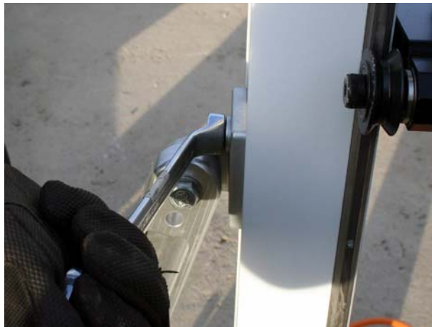
e. När rälsen är i rätt position, dra åt bulten ordentligt.
