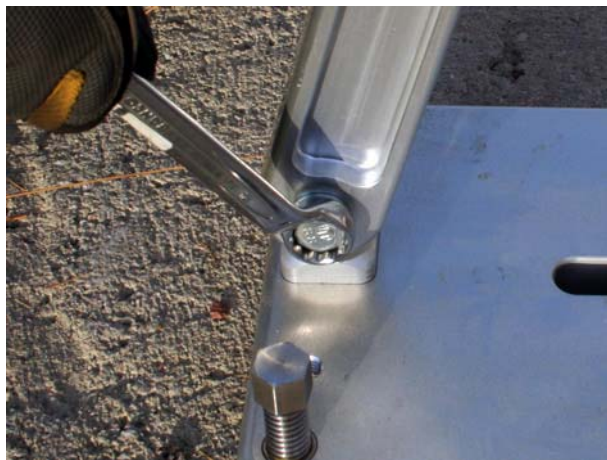
g. Dra åt den nedre bulten på bakstödet.
