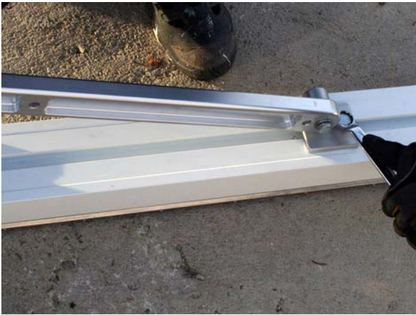
d. Ziehen Sie die obere Schraube locker zu.
